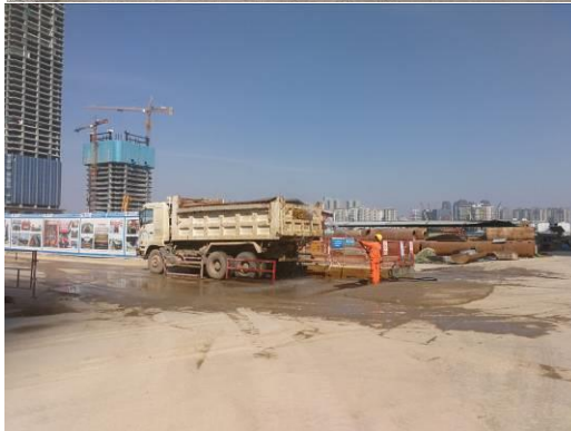
洗车平台及车辆冲洗、喷水雾降尘
