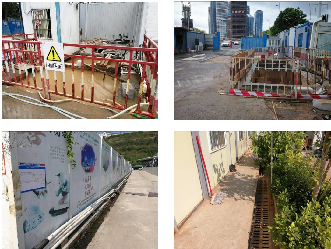
施工期水环境保护措施
