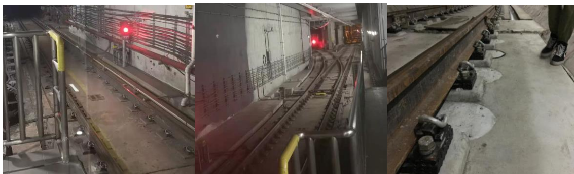
中等减振（双层非线性减振扣件）
