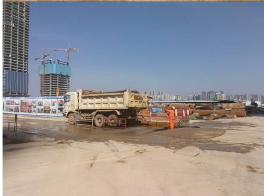
洗车平台及车辆冲洗、喷水雾降尘
