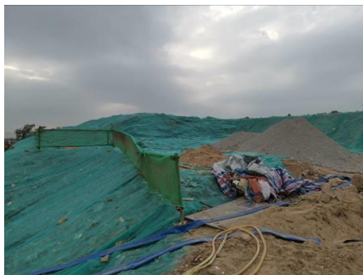
裸露土方、散装物料遮盖
