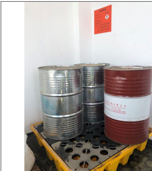
密闭式危废暂存间内部
