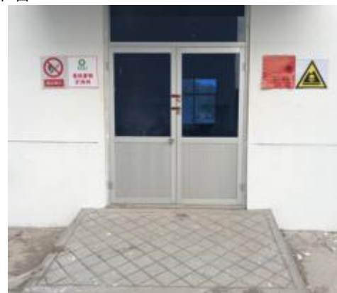
危险废物暂存间
