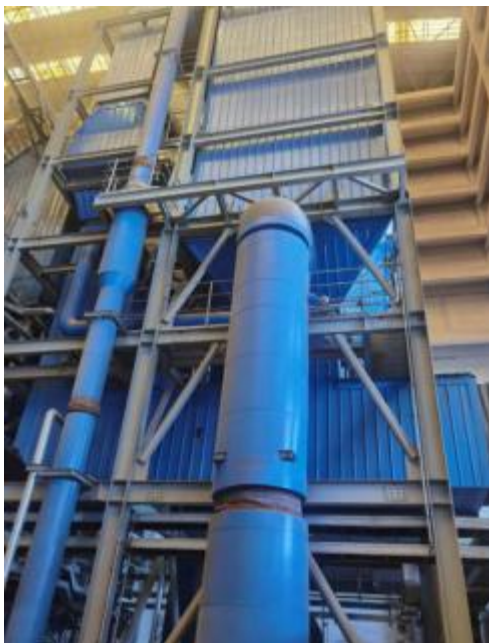
SCR处理装置（安装完毕，未投入使用）
