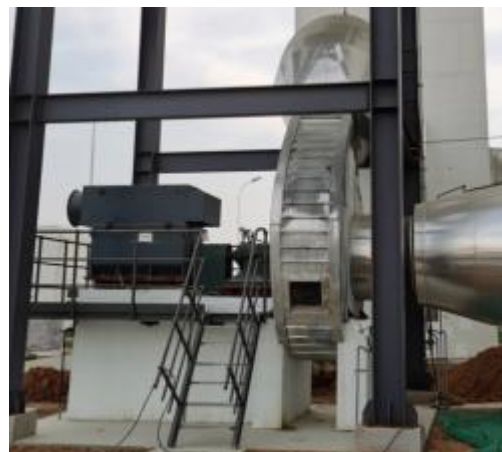
风机基础减振
