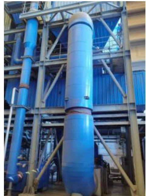
SCR处理装置（安装完毕，未投入使用）
