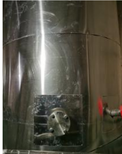
本项目废气排气筒出口采样位置
