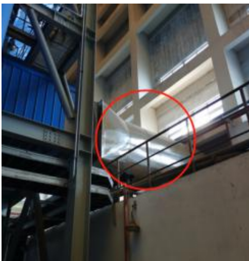
SCR处理装置（安装完毕，未投入使用）
