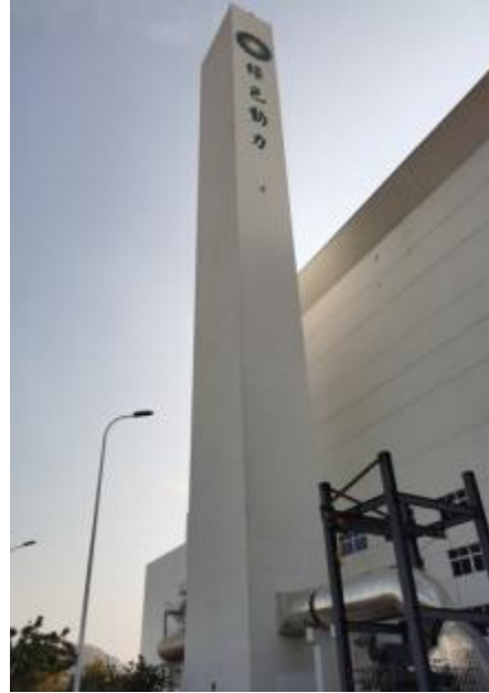
焚烧烟气排气筒外部套筒
