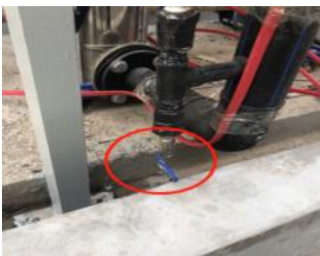
渗滤液处理系统出口采样位置
