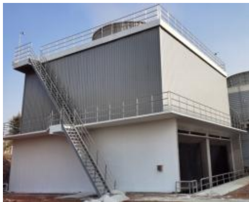
冷却塔水泥墙
