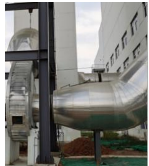
SCR处理装置（安装完毕，未投入使用）
