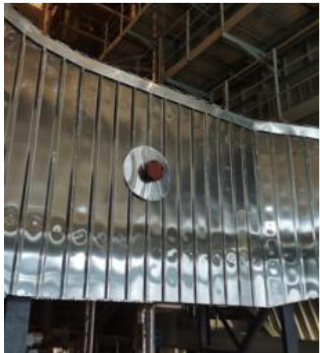
烟气处理设备（脱酸塔前）进口采样位置
