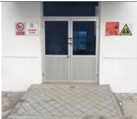
危险废物暂存间
